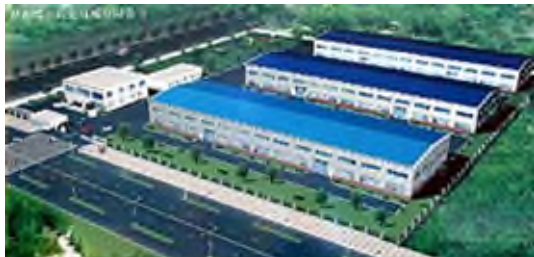
(昆山清陽精密機械) 工場外観
